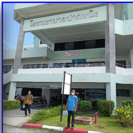
งานผลิตตรวจสอบคุณภาพน้ำในระบบจ่าย (เดือนละ1 ครั้ง)
